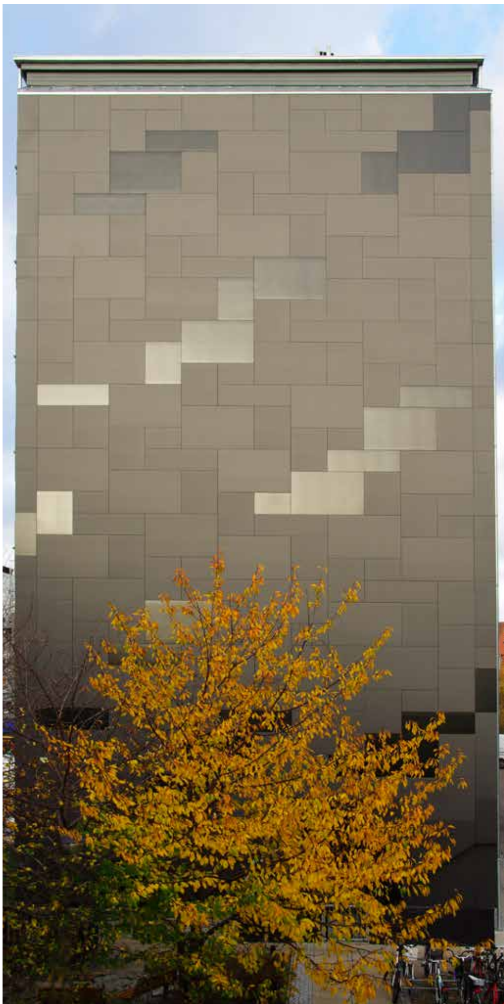
Den del af ventilationsanlægget, som sidder indvendigt i ejendommen, har et diskret og minimalistisk udtryk.
